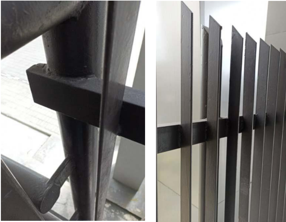
FIG. 06 – DETALHE DE LIGAÇÃO SOLDADA (MONTANTE CIRCULAR / PERFIL LONGITUDINAL E BARRA CHATA) / GRADIL EM BARRA CHATA (DETALHES)
