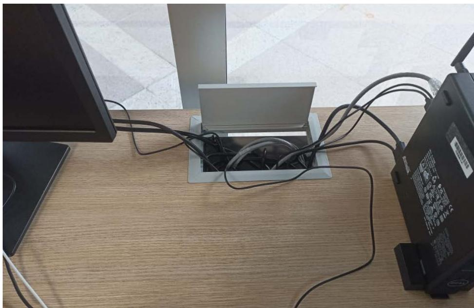
**FIG. 03** – Caixa de Tomadas Embutida p/ 06 Módulos (04 Tomadas 20A + 02 Tomadas RJ45)
